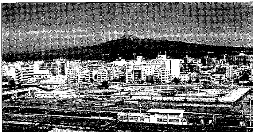
沼津駅北口広場（平成14年9月19日撮影）
